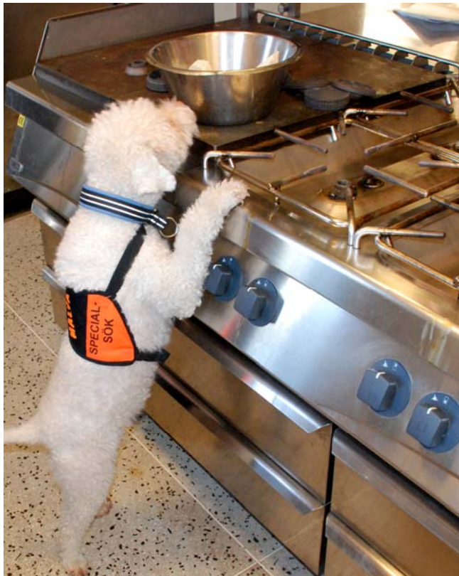
Malva söker av köket efter gasolläckan, som dock var riggad under spisen vid ledningens av och på kran, som denna duktiga hund snart nog markerade.
